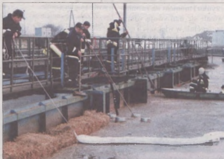
Oczyszczalnia w Chwałkowie
