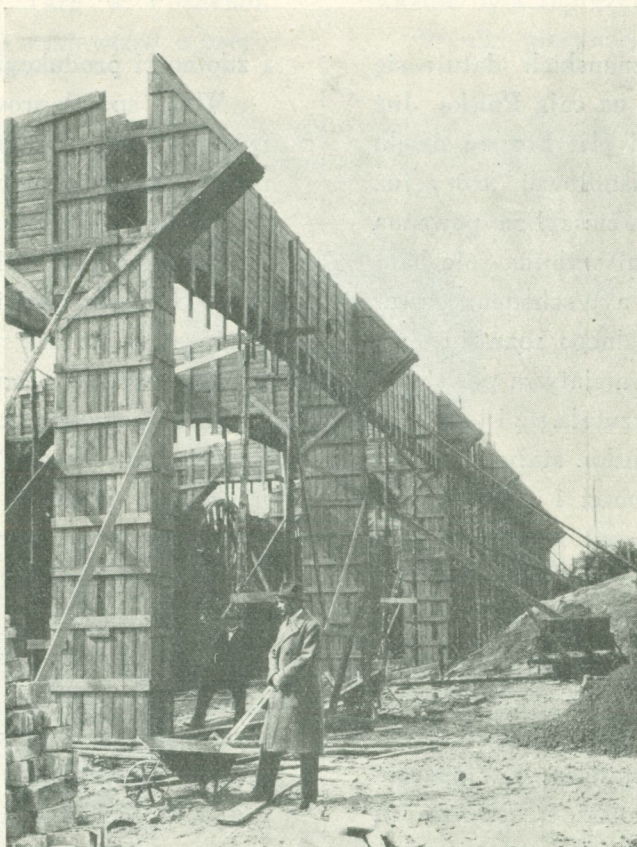
FRAGMENT HAŁY CIĘŻKIEGO PRZEMYSŁU (W BUDOWIE)
