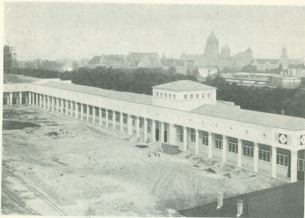
HALA CENTRALNA OD STRONY DZIEDZINCA
