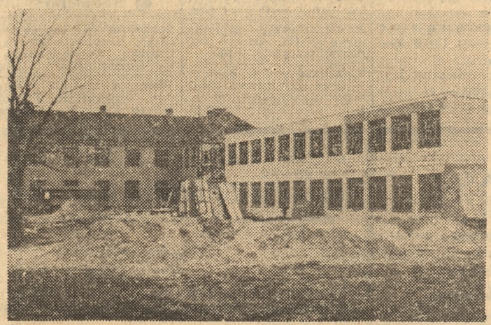
Trwa rozbudowa szkoły gminnej. W nowym budynku mieścić się będą m. in. sale lekcyjne i biblioteka. Zmodernizuje się również stary budynek, przystosowując całość do wymogów szkoły 10-letniej.
