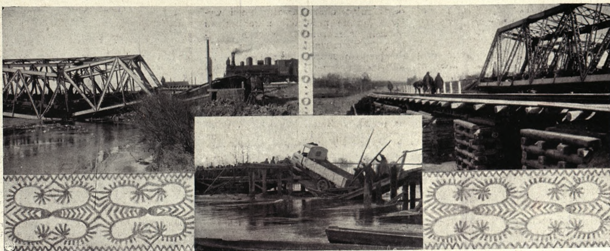
Z lewej: zburzony most. Z prawej: naprawa mostu. Na dole: zawalenie się mostu pod ciężarem samochodu wojskowego.
