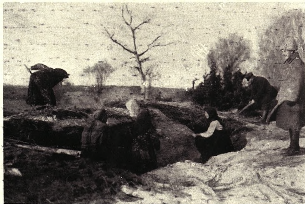
Przy budowie okopów pracują i kobiety wiejskie.
