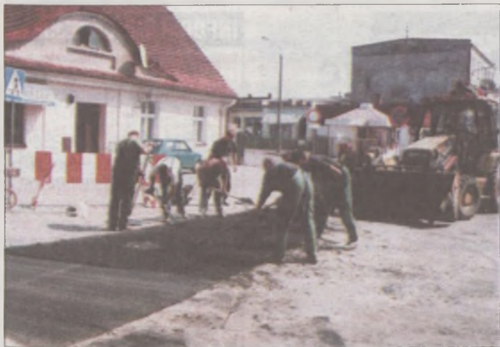
Remont ul. Wałowej
