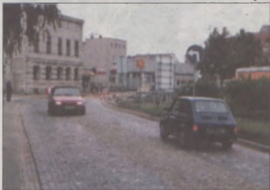
zebraniu i ponownym ułożeniu nawierzchni jezdni i chodników z kostki brukowej. Zakończone zo-
