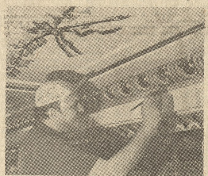
W pomieszczeniach na pierwszym piętrze Zamku Królewskiego w Warszawie złożone są ozdobne elementy. Moniowane są jednocześnie boazerie. Zajmują się nimi wykonawcy boazerii, pracownicy fabryk mebli w Bydgoszczy i Nowem. Na zdjęciu: Jan Sienbok złoci elementy sufitu w Sali Audiencyjnej.
