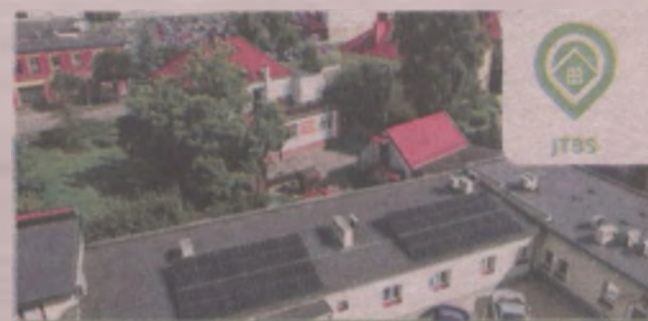
29 paneli o mocy 10 kW
