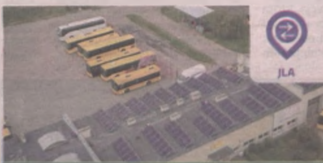
147 paneli o mocy 50 kW
