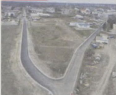
Inwestycja na ulicach Zacisznej i Przemysłowej kosztowała ponad 1,5 mln zł
