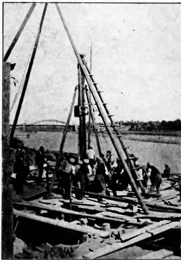
Zabijanie ścianki szczelnej przy ujściu kanału burzowego do Warty koło starych łązienek rzecznych.
