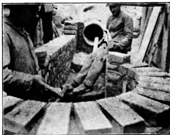
Budowa komory kaskadowej na Terenach Targu Poznańskiego.
