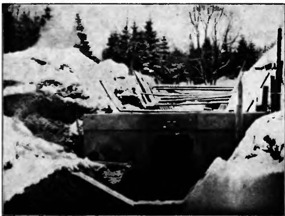
Budowa przepustu dla Bogdanki w ul. Niestachowskiej.
