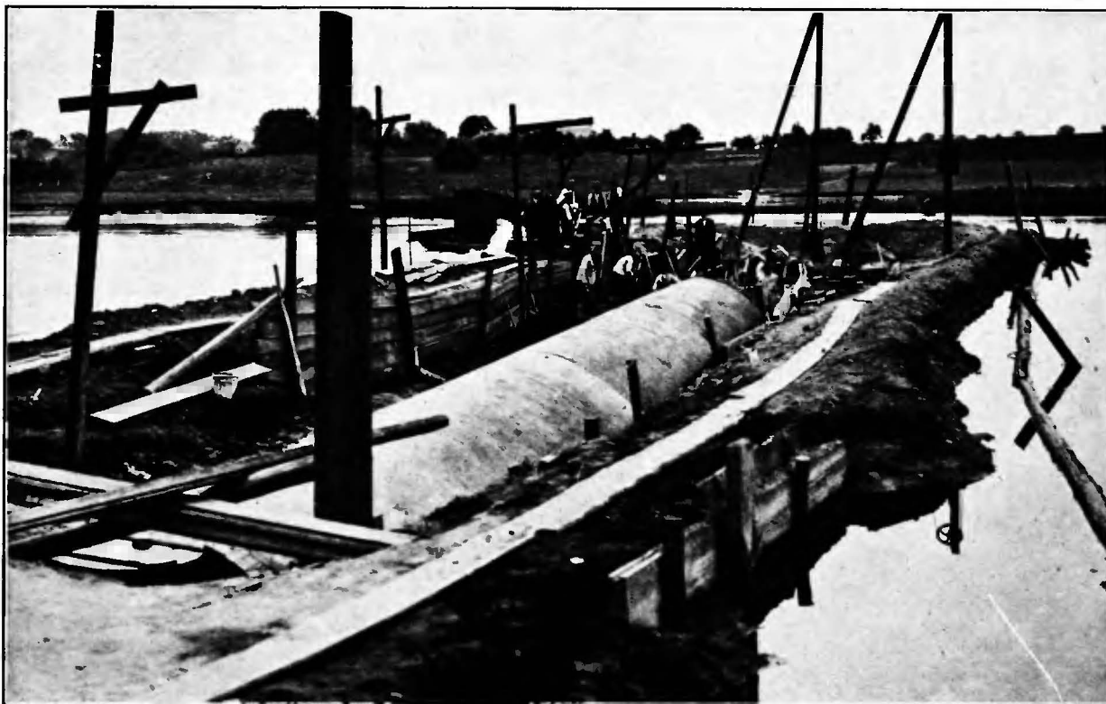
Budowa kanału burzowego przez stare koryto Warty w czasie przybierania wody.
