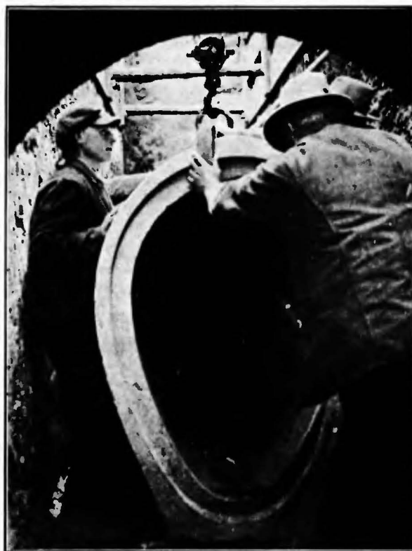
Układanie kanału z rur falcowych 80/120 cm w al. Okrężnej przy Szpitalu Dżakonisiek.
