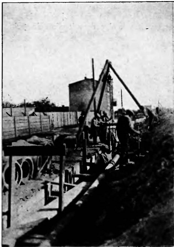
Kanalizacja ul. Lodowej.
