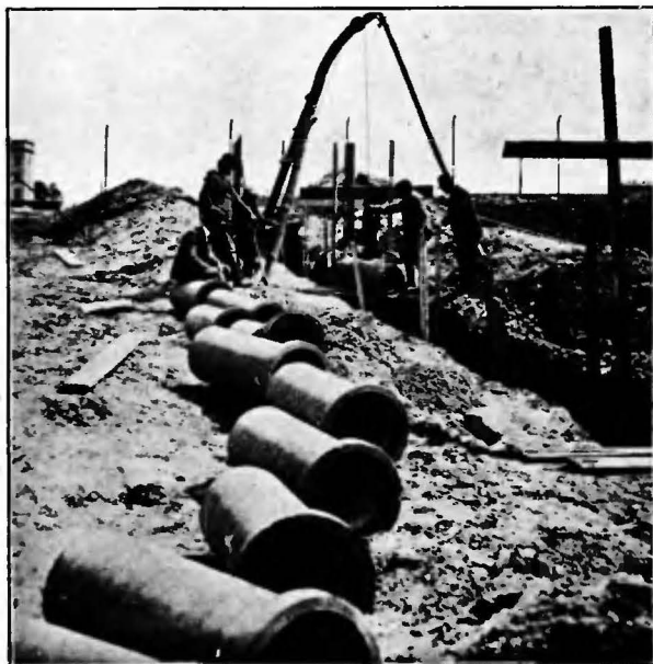
Budowa kanału z rur cementowych mufowych na terenach P. W. K.
