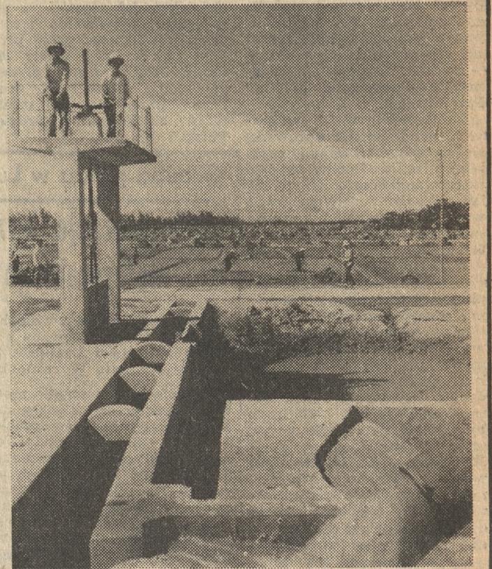
Spółdzielnie z prowincji Thai Binh (DRW) zajmujące się produkcją soli starają się zwiększyć produkcję. Na zdjęciu: zbiornik do słonej wody zasilany pompami mechanicznymi. Pięciokilometrowy kanał prowadzi do słonych oczyszczalni Dai Dong, skąd czerpie się solankę. CAF — fot. VNA
