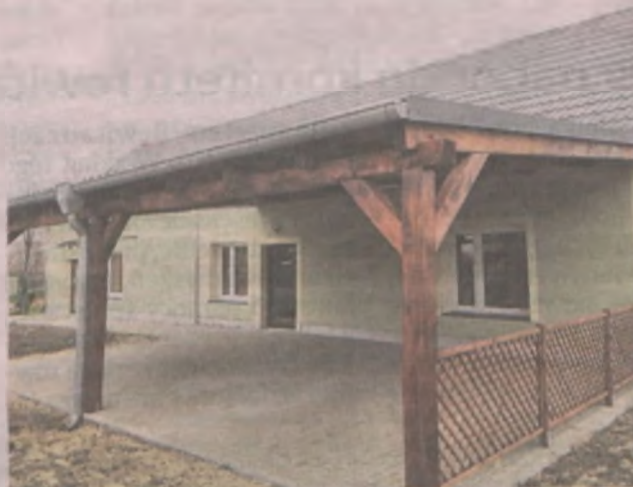
W ramach prac modernizacyjnych dobudowano rekreacyjną wiatę drewnianą oraz wymieniono eternitowe pokrycie dachu, przemurowano komin i co najważniejsze wykonano instalację odgromową. Dodatkowo docieplono budynek oraz utwardzono pobliski teren
