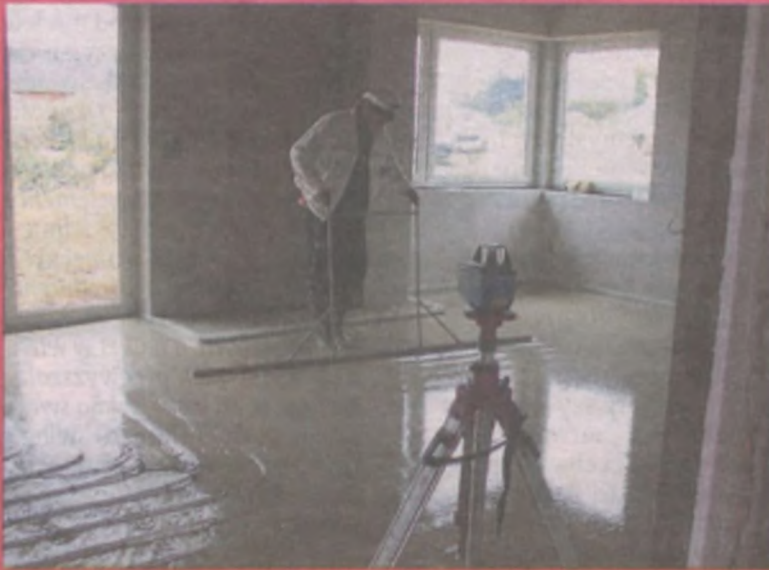
Samopoziomujące jastrychy anhydrytowe cechują się lepszą przewodnością ciepła i wytrzymałością niż wylewki betonowe. Dlatego lepiej nadają się na ogrzewanie podłogowe
