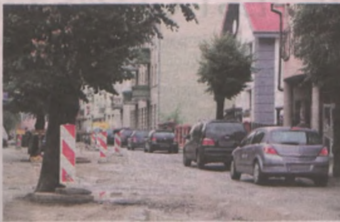
Prace związane z wymianą sieci podziemnych na ul. Wolności w Jarocinie powinny się zakończyć na przełomie września i października 2021
