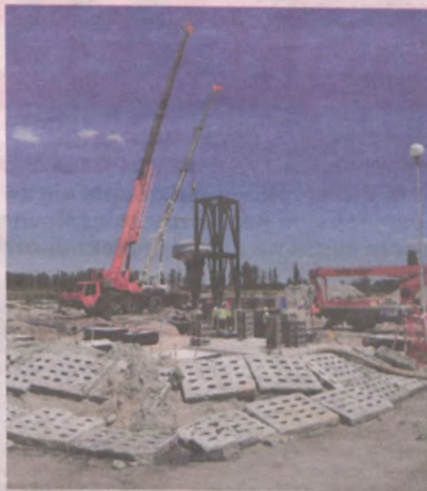
Krakowska firma Control Process rozpoczęła modernizację oczyszczalni ścieków w Cielczy w czerwcu ubiegłego roku
