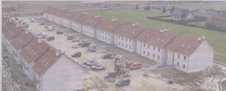
Drugie osiedle mieszkań czynszowych przy ul. Siedleńskiej jest na ukończeniu. Budynki będą musiały jednak - ze względu na stan epidemii - poczekać na zasiedlenie
