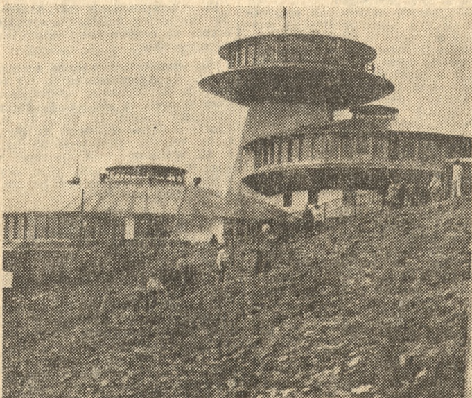
Tak prezentuje się budowane na szczycie Śnieżki schronisko i obserwatorium PIHM.
