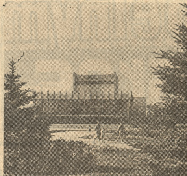
W Woroszyłowgradzie (Ukraińska SRR) zbudowano nowoczesny budynek teatru muzyczno-dramatycznego. Fot. — CAF
