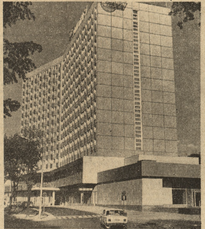
Po 15 miesiącach budowy stanął w Poznaniu nowy orbiowski hotel „Polonez”. Przy al. Stalingradzkiej wyrosła efektowna bryła 14-kondygnacyjnego budynku.
