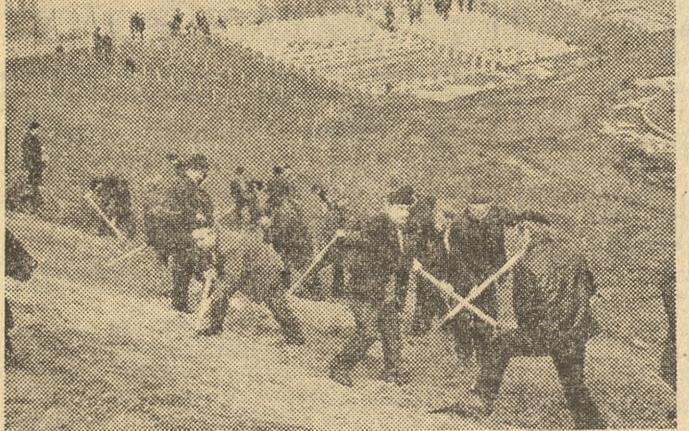
W ubiegłą niedzielę ponad 300 górników KWB „Konin” pracowało przy budowie Stadionu XXX-lecia w Koninie. Fot. — R. Fórmanek
