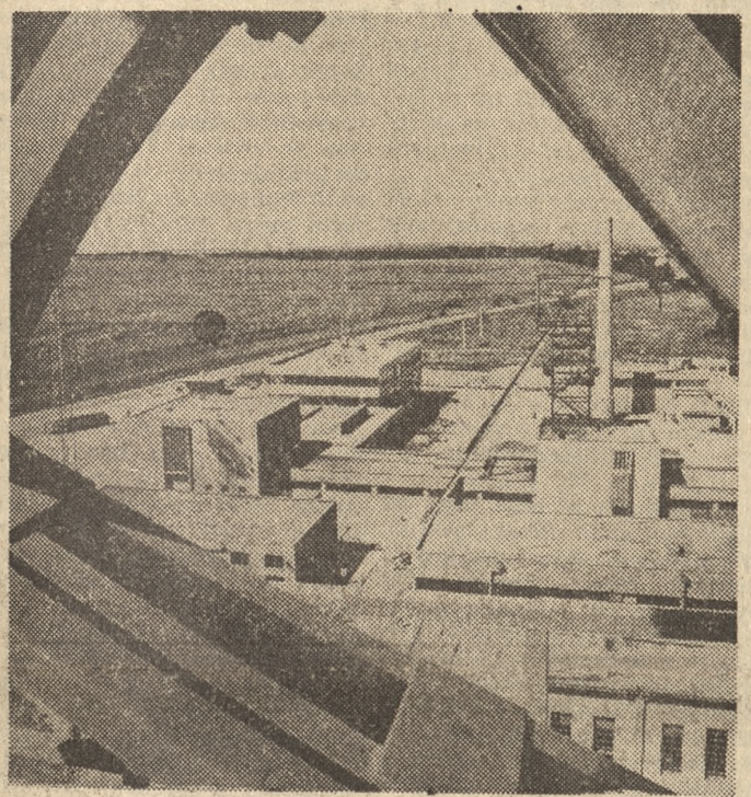
Węgry. Jedna z większych inwestycji 1973 roku — to kopalnia boksytu „Halimba III”. Roczna wydajność wyniesie tu 600-800 tysięcy ton. Na zdjęciu: zabudowa kopalni.
