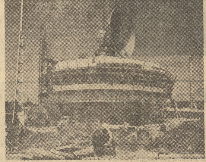
W Psarach (woj. kieleckie), w pobliżu góry św. Katarzyny, trwa budowa stacji satelitarnej. W lipcowe święto, z jej pomocą poprzez sputnik, emitowany będzie pierwszy program moskiewskiej telewizji. Stacja stanowi jedno z ogniw sieci łączącej kraje socjalistyczne w systemie „Intersputnik”. W przyszłości będzie można podłączyć ją do systemu „Eurowizji”. Koszt inwestycji wyniesie ponad 226 mln zł. Stacja w Psarach wyposażona została w aparaturę sprowadzoną ze Związku Radzieckiego. Fot. CAF — Rozmysłowicz
