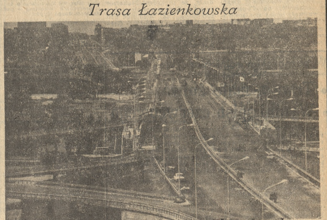
Budowa 17.500-metrowej Trasy Łazienkowskiej dobiega końca. Trwają już na niej ostatnie prace kosmetyczne. Na zdjęciu: panorama Trasy Łazienkowskiej od strony praskiej. Fot. — CAF
