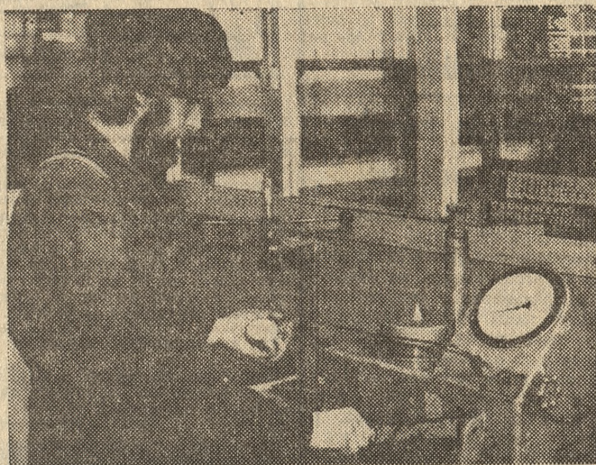
Kontrola regeneracji końcówki wtryskiwacza w Zakładzie Naprawy Mechanizacji Rolnictwa w Poznaniu.
