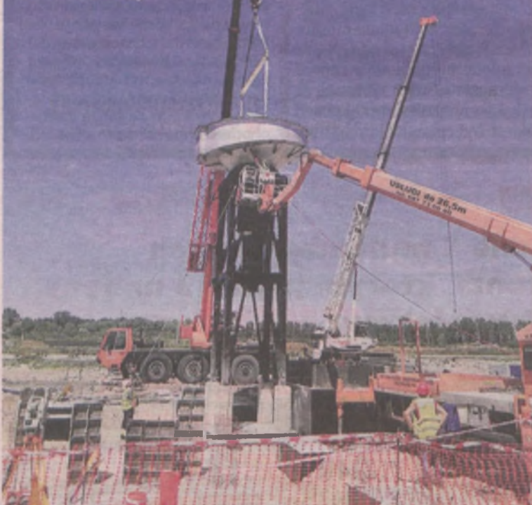
Montaż nowoczesnej instalacji na terenie oczyszczalni ścieków w Cielczy
