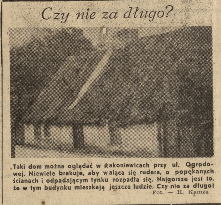
Taki dom można oglądać w Rakoniewicach przy ul. Ogrodowej. Niewiele brakuje, aby walcę się rudera, o popękanych ścianach i odpadającym tynku rozpadła się. Najgorsze jest to, że w tym budynku mieszkają jeszcze ludzie. Czy nie za długo!
