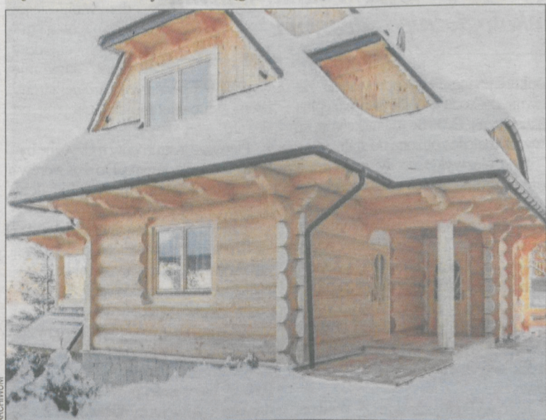
Produkcja drewnianych domów chroni nas także przed efektem cieplarnianym
