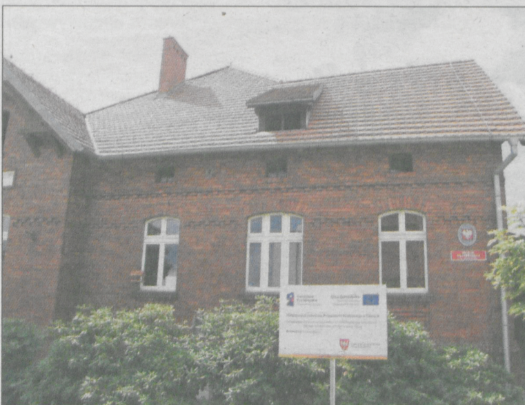
Modernizacja przedłuża się z powodu złego stanu budynku
