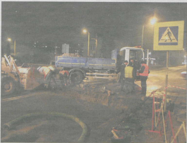
Usuwanie uszkodzonego wodociągu
