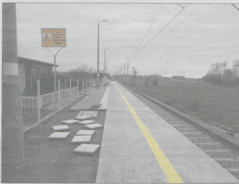
Na stacji w Cieszkowie trwają ostatnie prace
