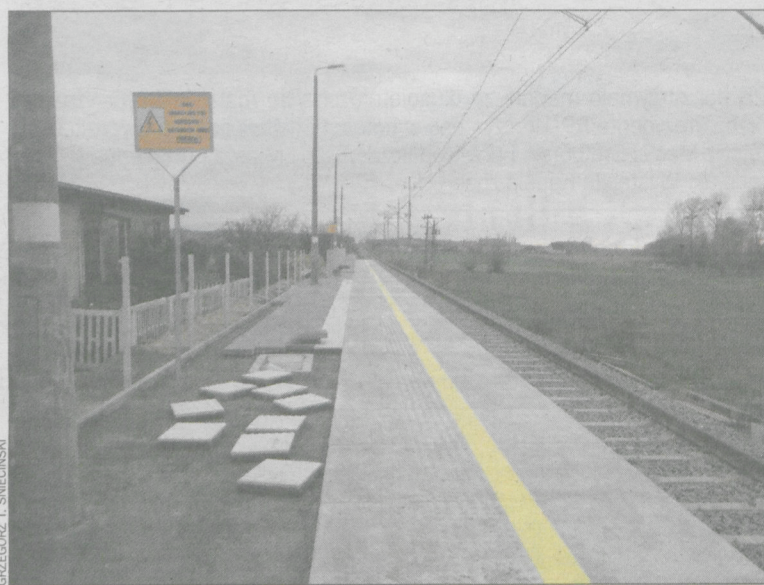
Na stacji w Cieszkowie trwają ostatnie prace
