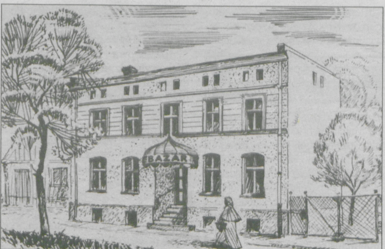
Dawny budynek Bazaru, al. Powstańców Wielkopolskich (przedszkole Bajka)
