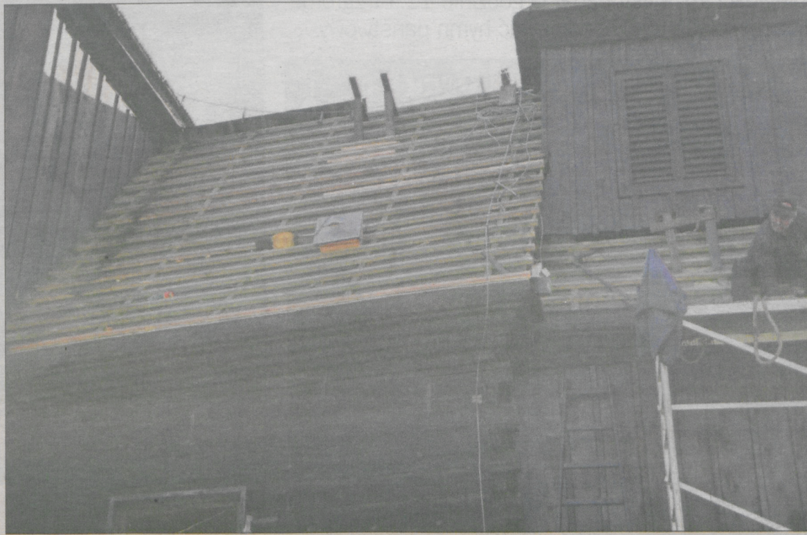
Fragment dachu po przełaczeniu. Po zdjęciu gontu zerwano łąty i ułożono je w równym rozstawie. Dopiero wtedy montuje się dwuwarstwowo gont
