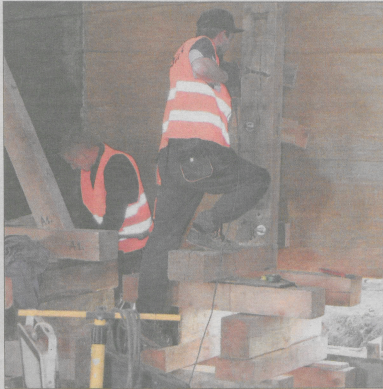
Z wnętrza wybrano metr piasku. Ścianę najpierw oparto na przyporze i stosie belek. Później (z prawej) montuje się podnośniki kozłowe, które zastąpią przyporę. Na końcu umieszczona zostanie podwalina
