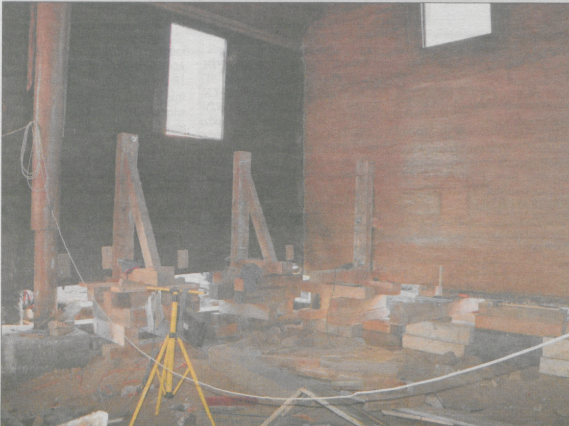
Konstrukcję trzymają w powietrzu podnośniki koźłowe oparte na stosie belek. Z lewej oryginalna podpora oczępu
