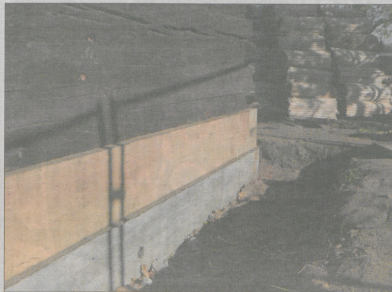
Tak wygląda gotowy fundament z dębową podwaliną (część południowa)
