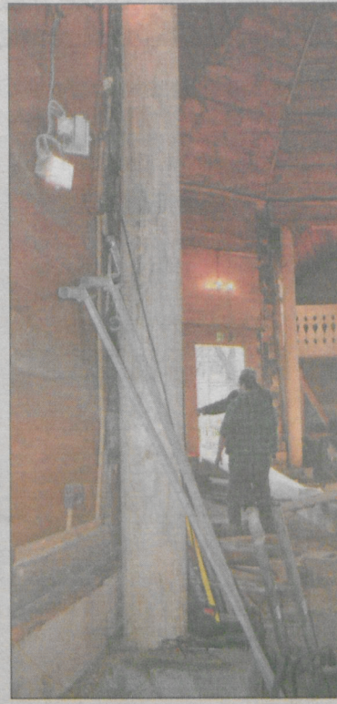
Nowa podpora oczepu. Teraz będą one w każdym narożniku budynku
