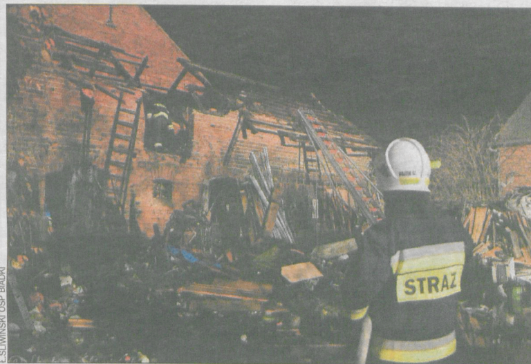
Po zgaszeniu pożaru materiały poddasza wyrzucano na zewnątrz
