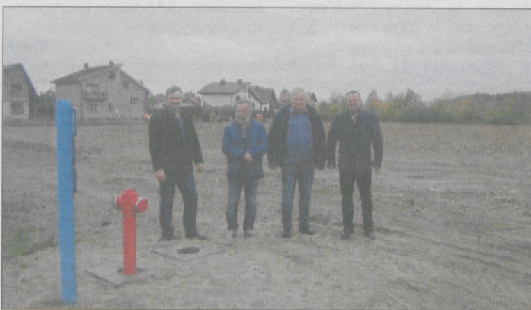
Odbiór prac z udziałem wykonawcy i urzędników
