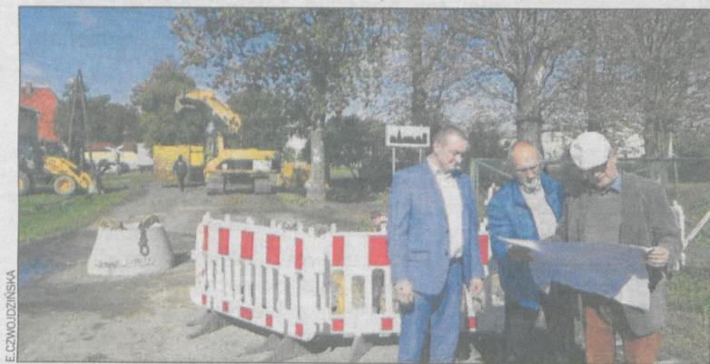
Przedsięwzięcie jest wielkim zadaniem inwestycyjnym gminy
