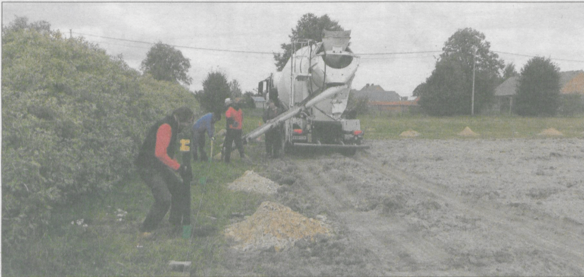
Trwają prace przy modernizacji boiska
