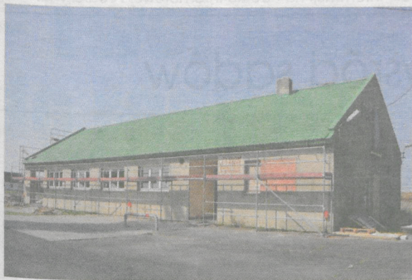
Remont świetlicy w Wyrebinie
