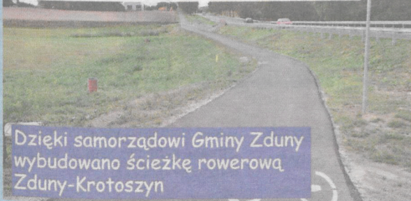
✓ Budowa ścieżek pieszo-rowerowych
