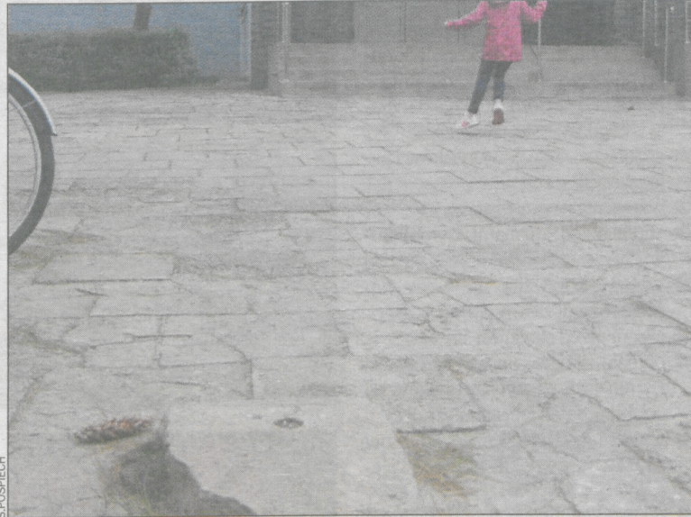
Cokół wystaje kilka centymetrów ponad nawierzchnię chodnika
