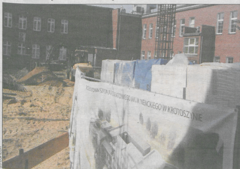
Rozbudowa szpitala na ul. Mickiewicza zakończy się równo za rok
