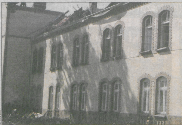
W trakcie rozbiórki spalonych elementów konstrukcji
