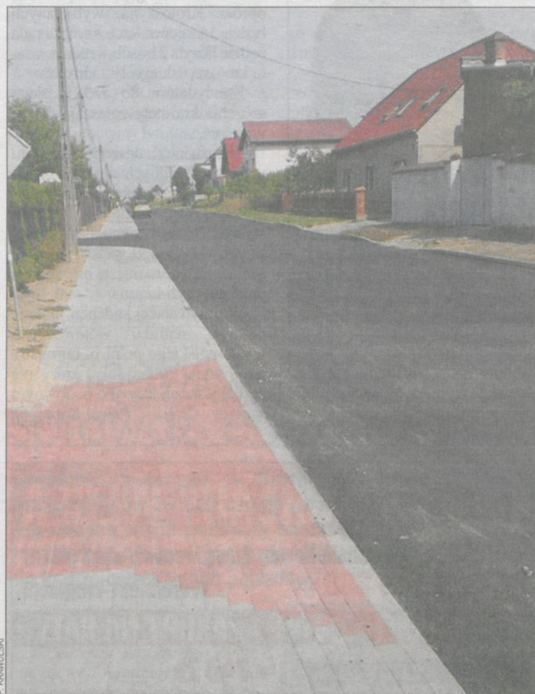
Tak wygląda ulica po zakończeniu pierwszego etapu prac
