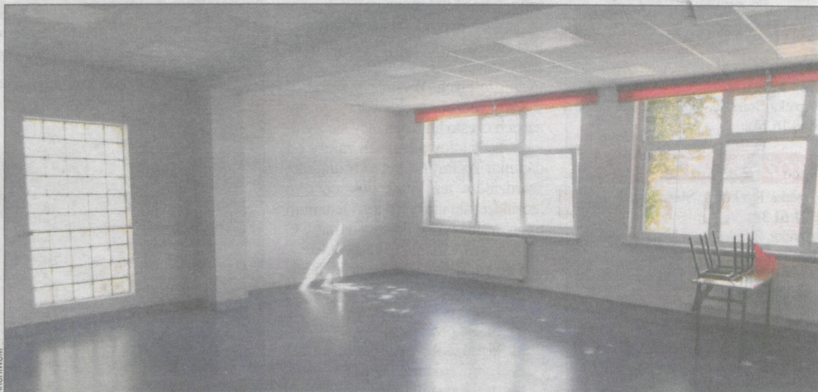
Pomieszczenie szkoły przy ul. 3 Maja po remoncie stropu
