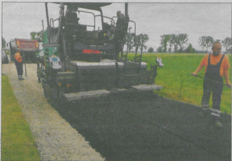
W trakcie prac na ul. Kwiatowej w Orpiszewie
