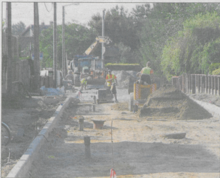
Prace idzie pełną parą
