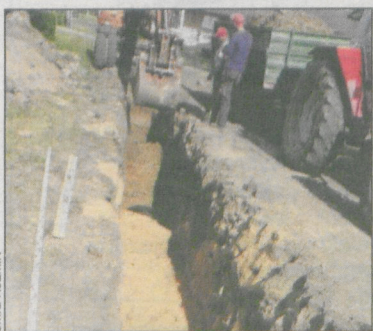
Prace wykonała firma z Kobylina
