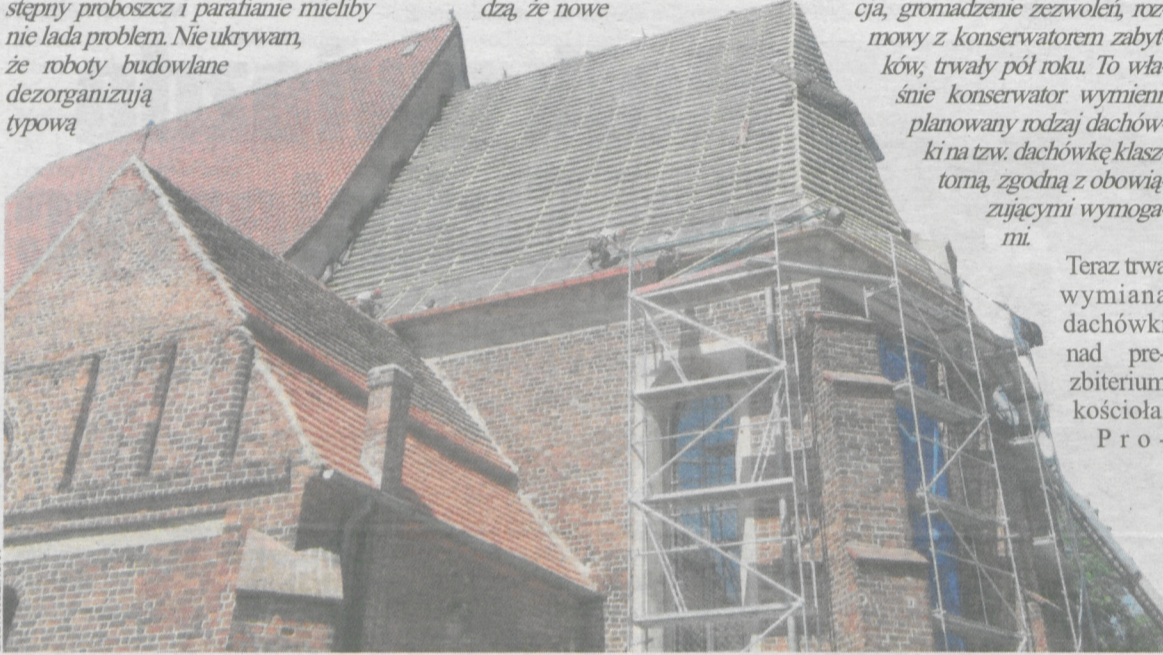
Remont dachu nad prezbiterium. Przyjechały dwa tiry dachówek
