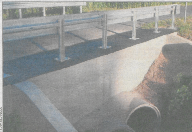
Po kapitalnym remoncie przepust spełnia swoją rolę
