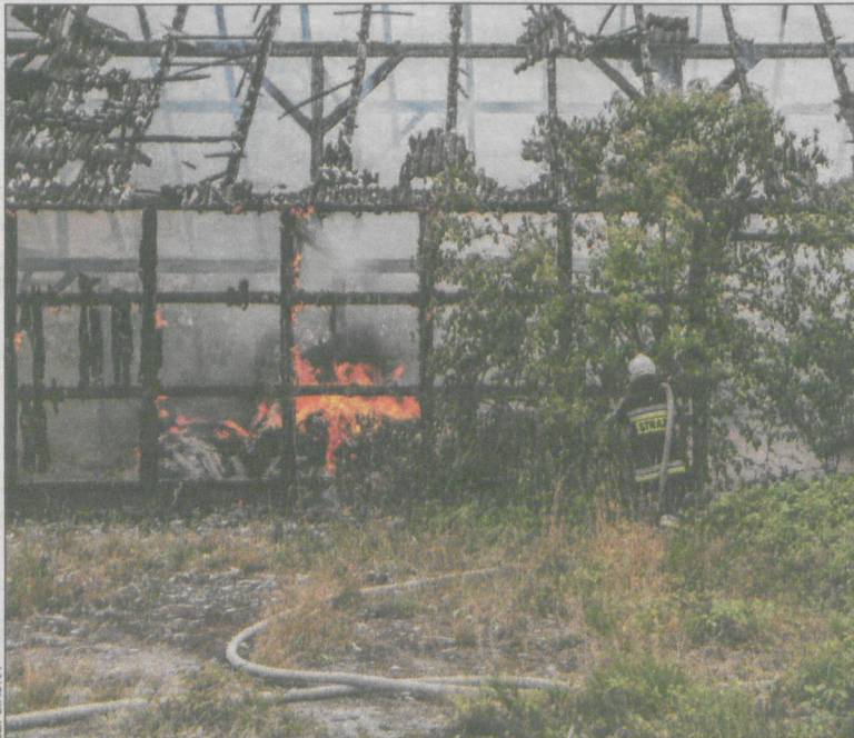
Drewniana konstrukcja budynku zawałiła się
