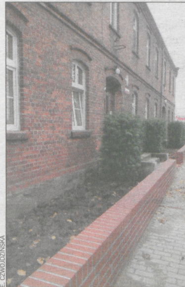
Jeden z remontowanych budynków
