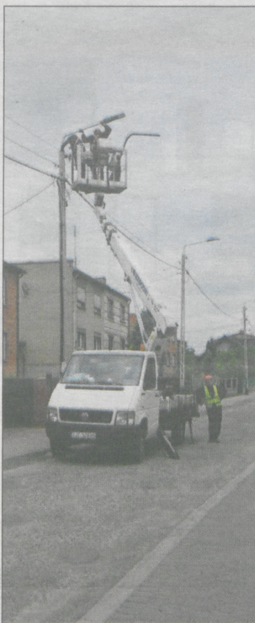
Podczas prac na ul. Witosza.
