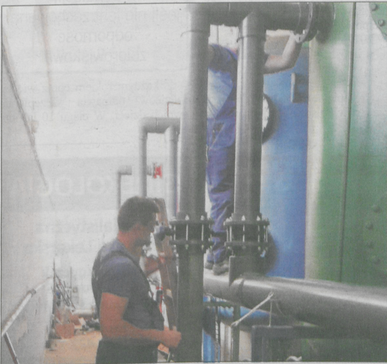
W trakcie remontu prawie 30-letniej filtrowni na ul. Ogrodowskiego
