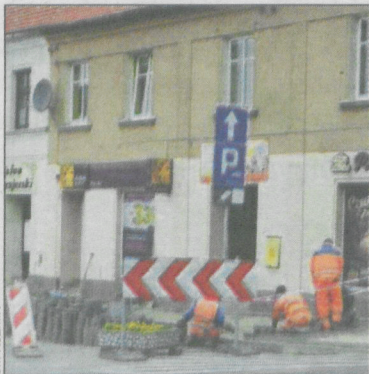
W trakcie pierwszego etapu prac
