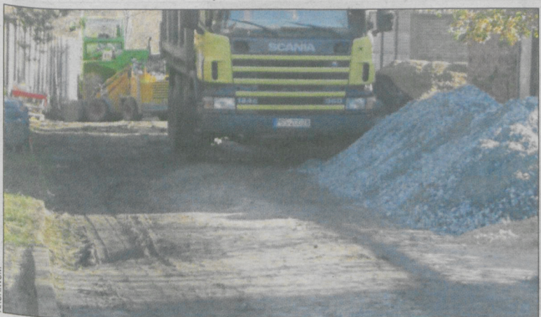
Prace ruszyły w listopadzie 2017 r.
