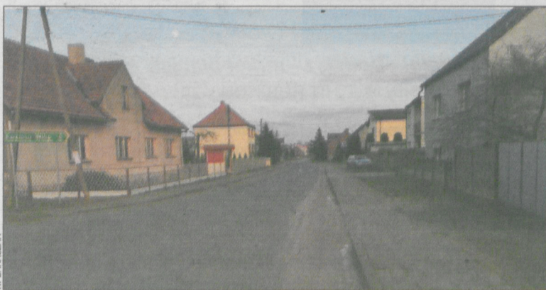
Kanalizacja poprawi komfort życia mieszkańców
