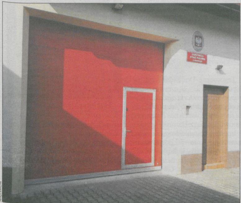
Starą drewnianą bramę zastąpiła metalowa
