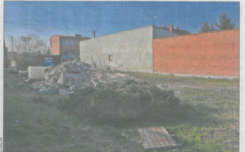
Na razie na wykupionej działce znajdują się materiały budowlane
