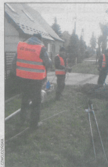
Pracownicy zadbali o wymianę słupów
