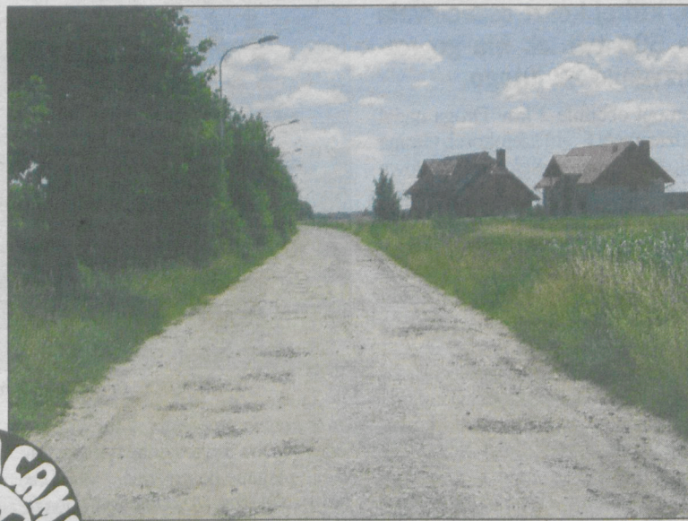
Czy sulmierzycanie doczekają się modernizacji Myśliwskiej
