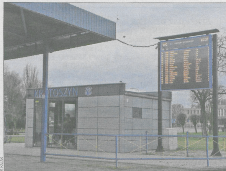
Tablice z elektronicznym rozkładem jazdy, obok budynek poczekalni
