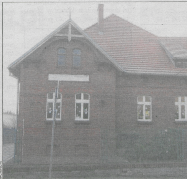
Przedszkole przejdzie gruntowny remont
