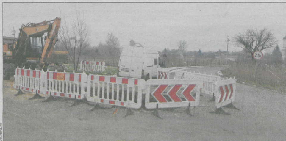
Prace ruszyły również na ul. Kopemika
