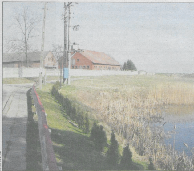
Chodnik przy stawie jeszcze przed umocnieniem brzegów
