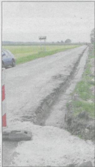
Trasę do skrzyżowania na Dąbrowę poszerzono w zeszłym roku
